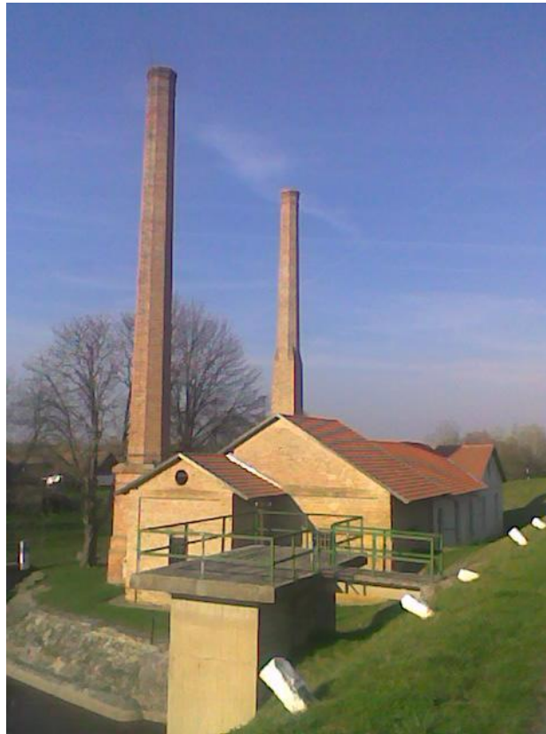
A sajfoki belvízátemelő szivattyútelep
