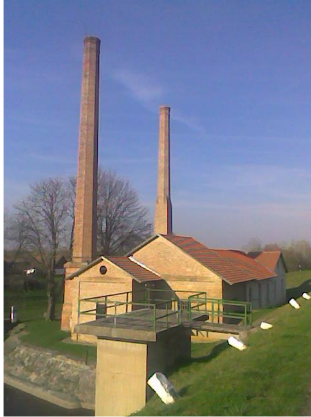
A sajfoki belvízátemelő szivattyútelep
