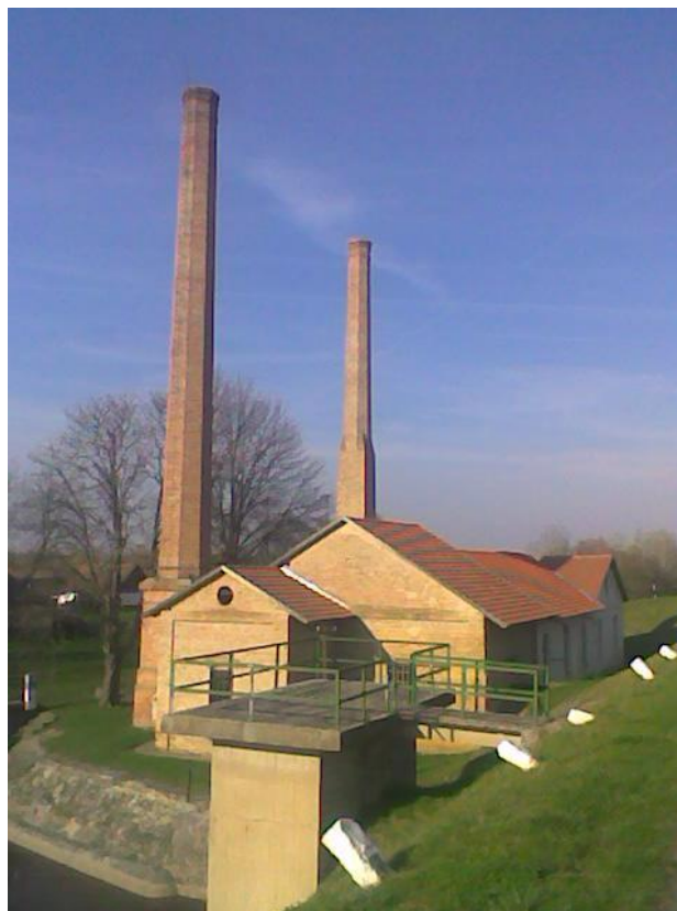
A sajfoki belvízátemelő szivattyútelep
