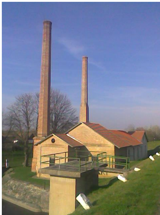
A sajfoki belvízátemelő szivattyútelep
