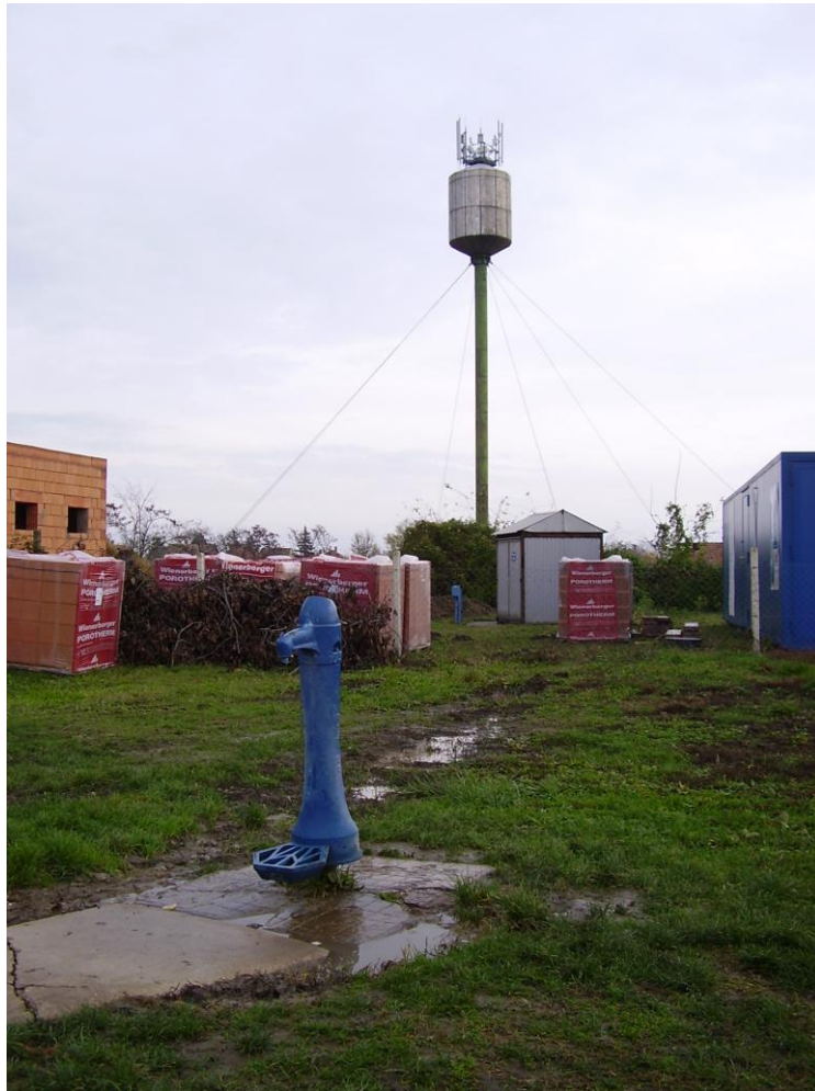
Az 50 m 3 térfogatú víztorony (hidroglóbusz)
