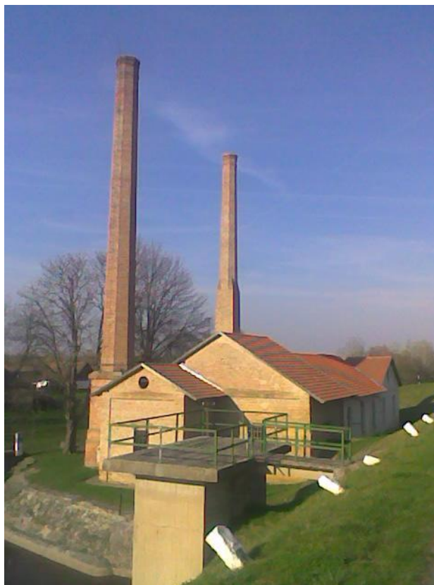
A sajfoki belvízátemelő szivattyútelep
